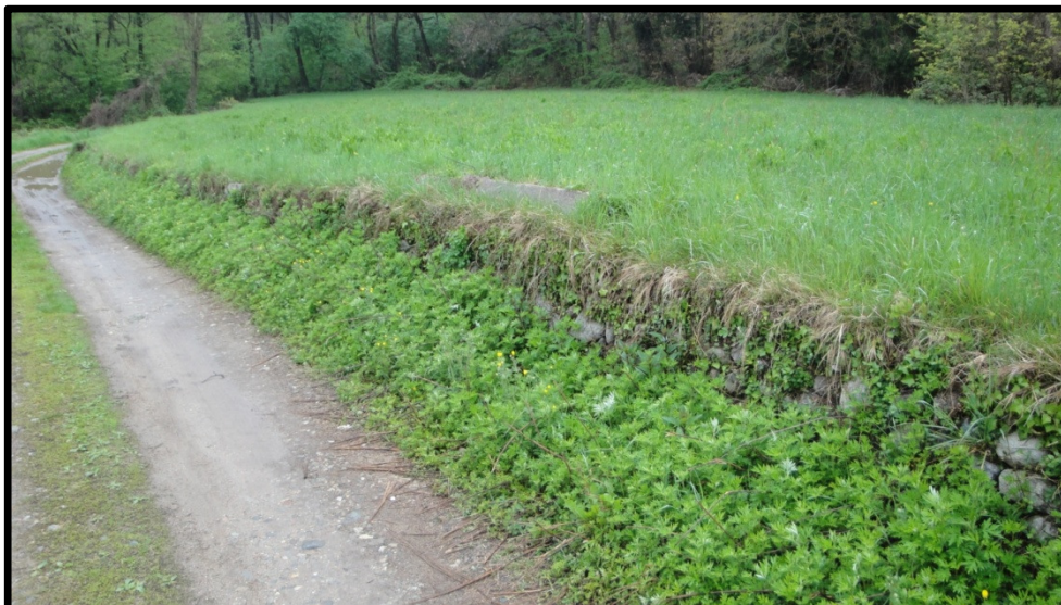
Fig. 25. Muretto a secco individuato nei pressi di Villadosia.
